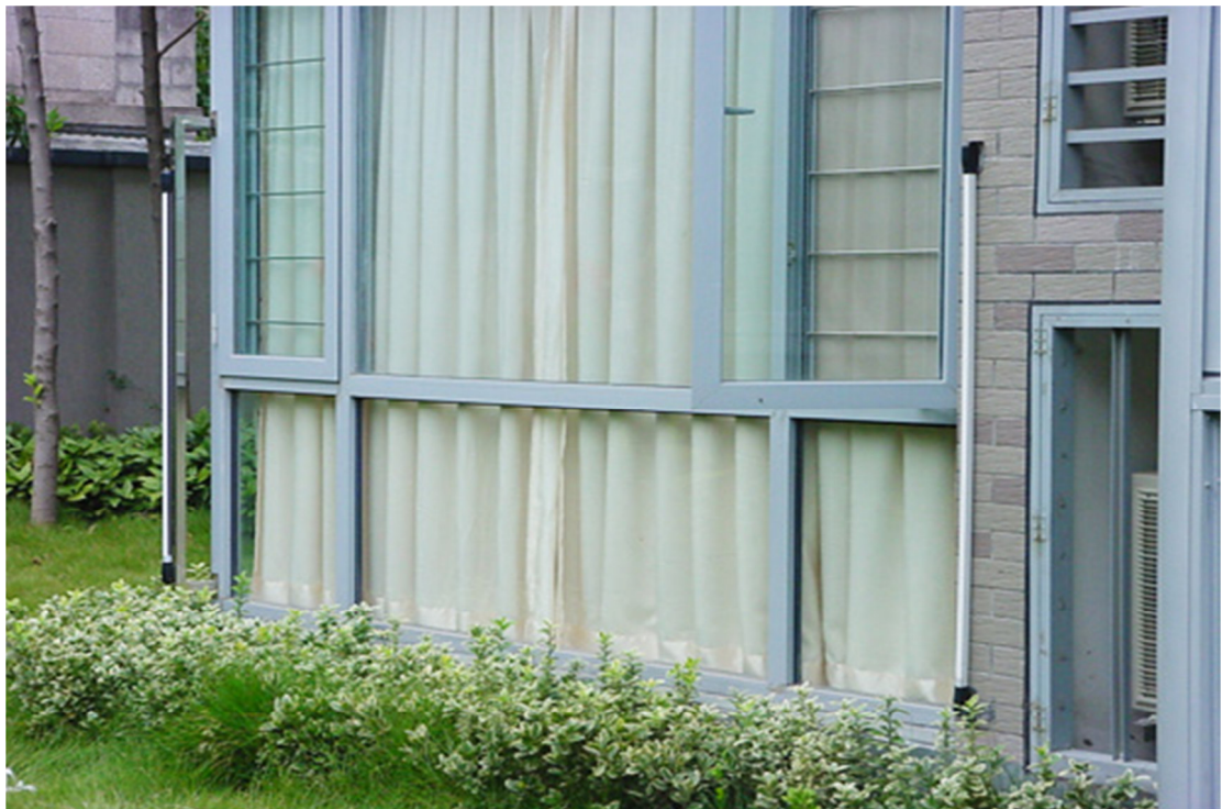
Рисунок 1.2 - Вариант установки извещателя для охраны оконного проема
